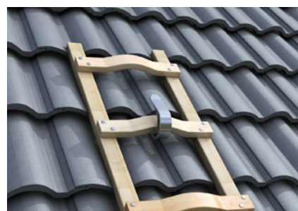
Abb. 66 Einhängen der Dachauflegeleiter
